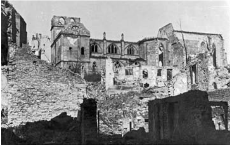
Abbildung 1: Blick von der Östlichen Karl-Friedrich-Straße nach Norden zur Schlosskirche, 1945 (Stadtarchiv Pforzheim, S1-04-005-S-033, Foto: Vogt)
