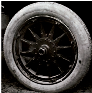
Abb. 2.64 (links): Das Hinterrad als „jante amovible“
