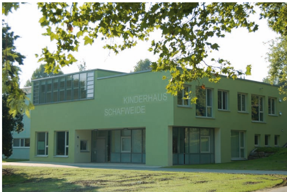
Das fertiggestellte Kinderhaus Schafweide im Sommer 2014.
