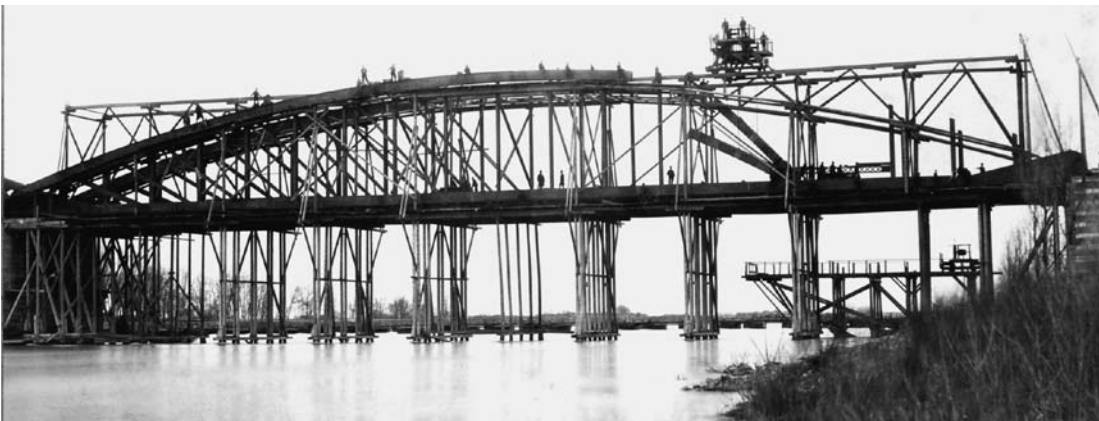
Abbildung 17: Bau der Eisenbahnbrücke über den Rhein bei Germersheim 1876, 3 x 90 m Spannweite [Privatbesitz Familie Benckiser].
