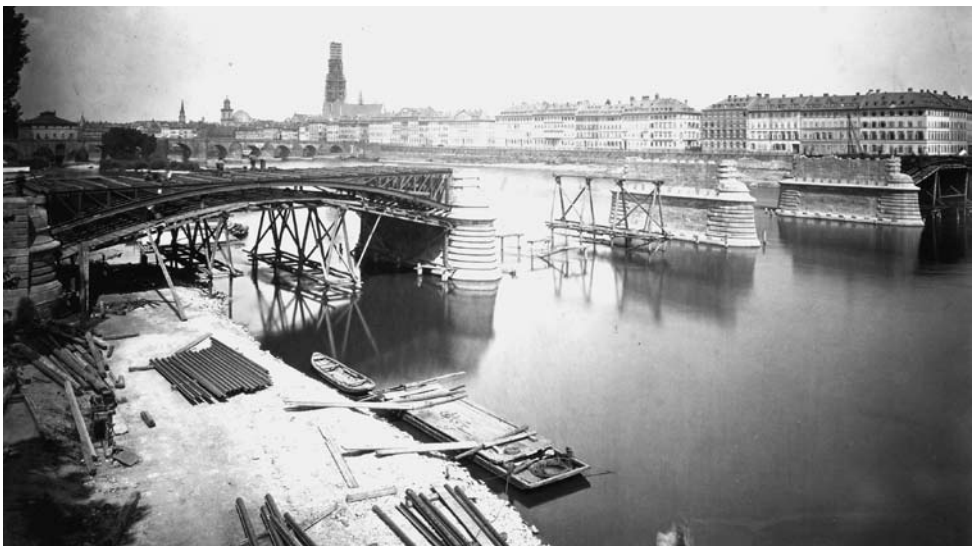
Abbildung 18: Bau der Obermainbrücke in Frankfurt 1877 [Privatbesitz Familie Benckiser].
