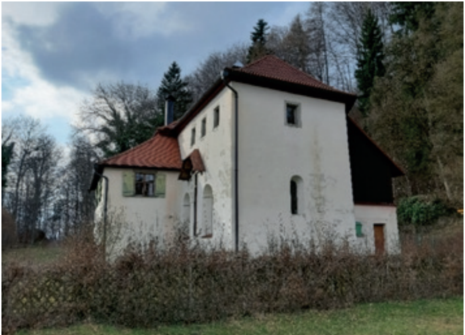
3a Die Kapelle im Ostteil der Klause Egg mit dem Wohntrakt im Westen und dem neuzeitlichen Wirtschaftstrakt (Ziegenstall) im Norden.
