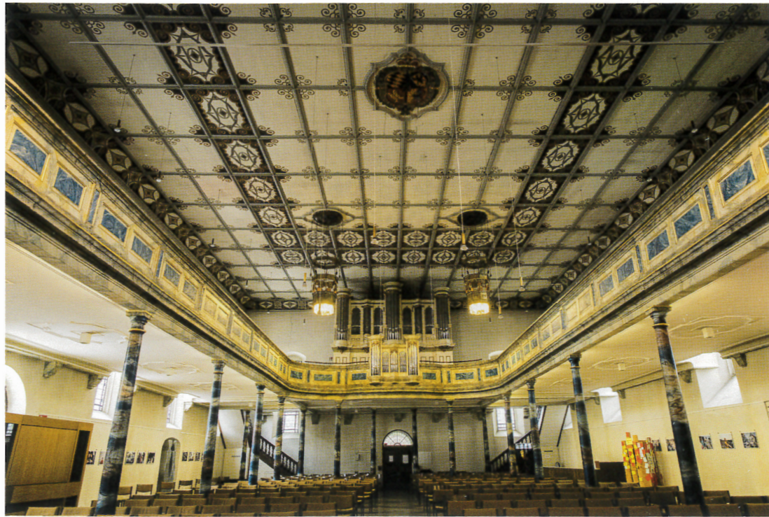
Abb. 9: Stadtkirche Göppingen, Innenraum: Die Decke mit 20 Meter Spannweite lässt nicht ahnen, dass sich über ihr ein dreistöckiger Fruchtkasten befindet (© AeDis AG für Planung, Restaurierung und Denkmalpflege 2020)
