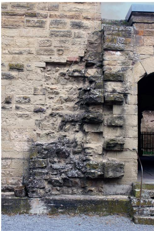
*Abb. 58: Neipperg, Hinterer Turm, Ringmaueransatz an der Südwestecke, rechts ein Teil der Torhalle von 1851 mit einer weiteren, nicht mehr benutzten Verzahnung.*
