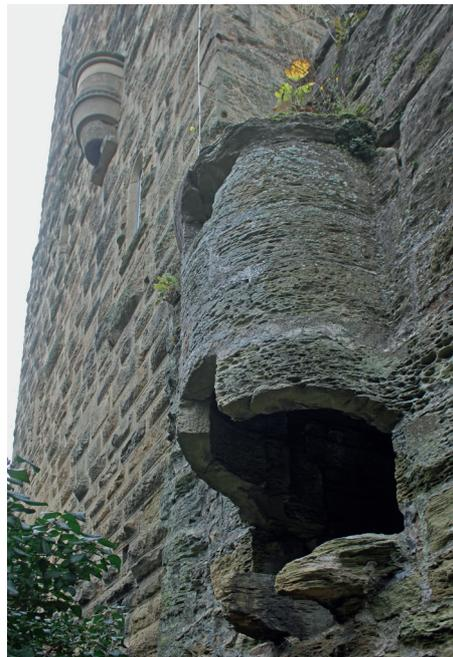
*Abb. 61: Neipperg, Hintere Burg, beschädigter Aborterker an der Ostmauer der Kernburg, dahinter der besser erhaltene Aborterker des Wohnturms.*
