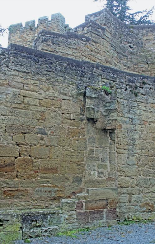
*Abb. 59: Neipperg, Hintere Burg, Teile der abgebrochenen Südmauer der Kernburg, die in der nachträglich abgeschrägten Südwestecke erhalten sind.*
