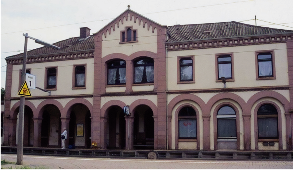
Abb. 6 Empfangsgebäude des Bahnhofs Kenzingen (Erik Roth, Landesamt für Denkmalpflege, 2002).
