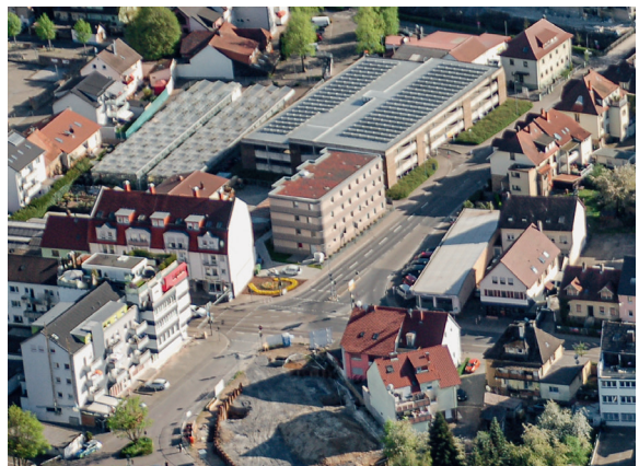
Ecke Dührener Straße und Hauptstraße 2020
