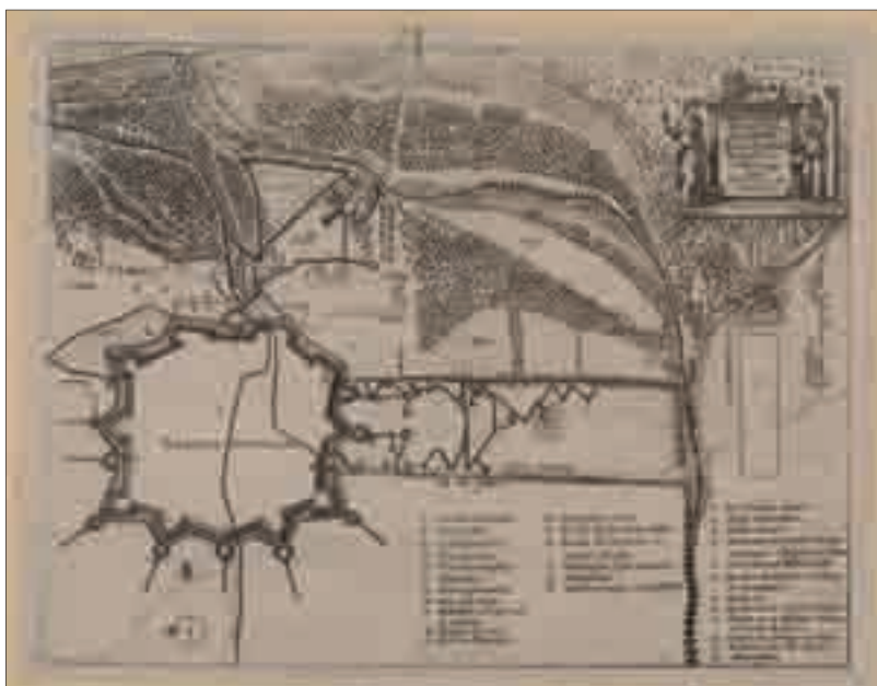
Abb. 3 Frankenthal unter spanischer Belagerung 1621, Kupferstich von Heinrich van der Borcht © rem Graphische Sammlung, REM_MG_6401
