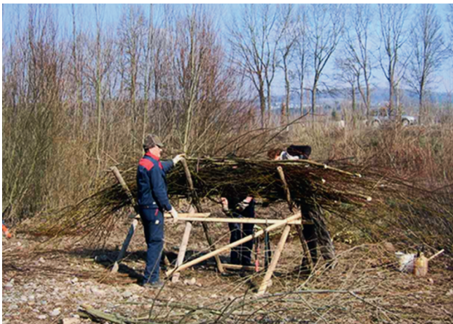
Abb. 20: Herstellen einer Faschine aus Weidenstangen.
