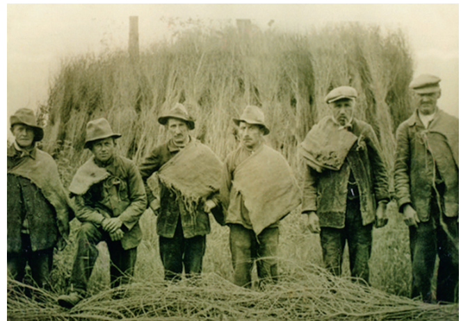
Abb. 22: Faschinenmacher beim Faschinentragen. Aufnahme: 1932.
