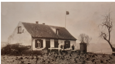
1913 wurde das Wohnhaus der Ziegelhütte als letztes der Gebäude abgerissen.
