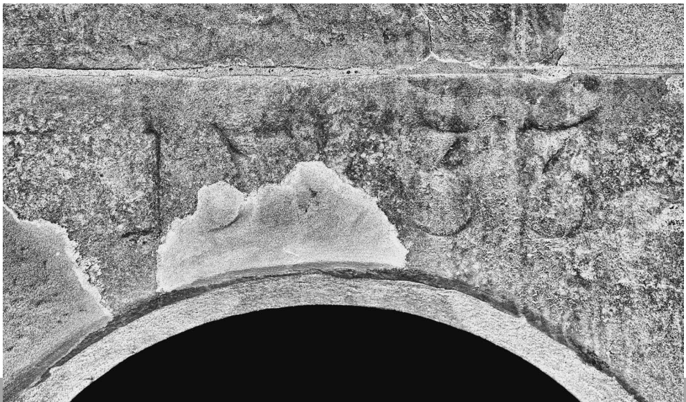
Abb. 57: Stift Sinsheim auf dem Michaelsberg. Kirchturm mit Bauinschrift 1533. Am Türbogen über dem Ausgang zur Kuppel. Außenseite. Die Jahreszahl zeugt vom Abschluss der Arbeiten am Turmbau.
