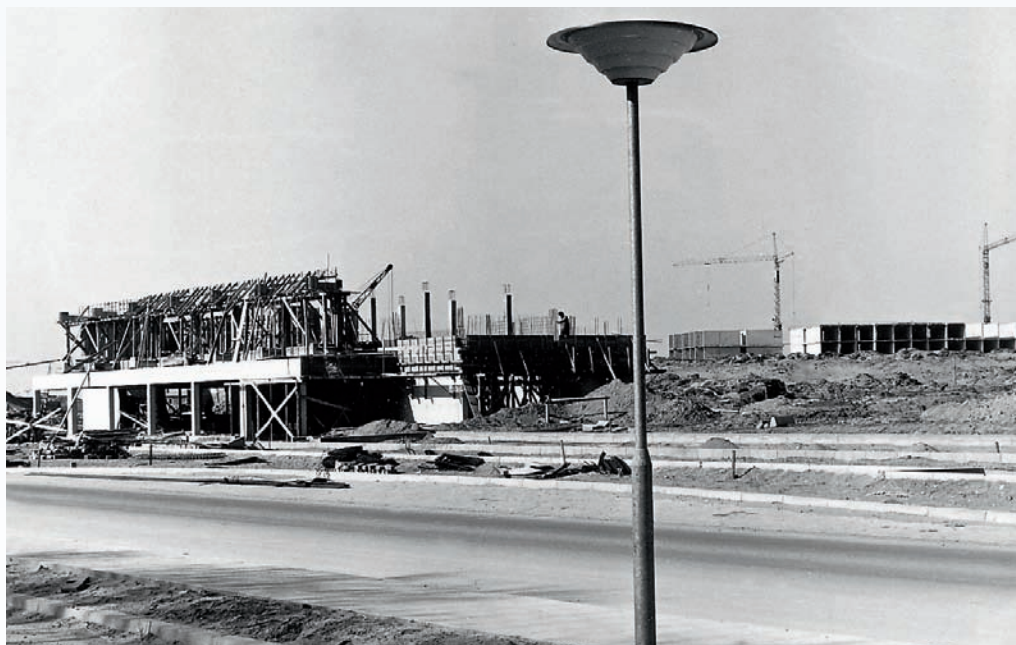
Beginn der Hochbauarbeiten: Im Vordergrund das Informationsgebäude, rechts hinten das Apartmenthaus „Am Park“
