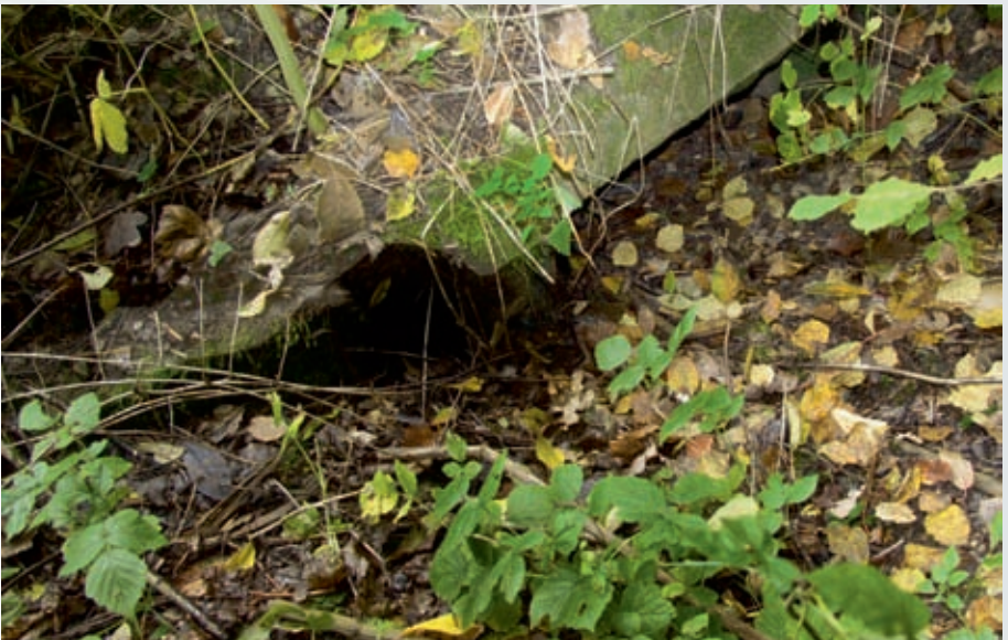
Abb. 3 Eine Dole an der alten Chaussee
