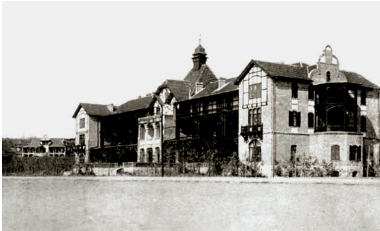
Das alte Strandhotel, heute als Bürogebäude genutzt
